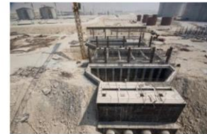
ساخت آبگیر با ظرفیت ۱۴۰ هزار متر مکعب
