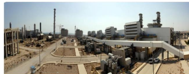
پروژه ایران الان جی، نمایی از کارگاه ساخت
