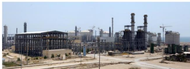
Site construction, Iran LNG Project
