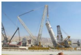
نصب برج جذب ۷۸۰ تنی
